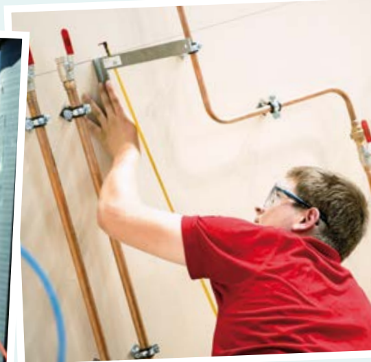
Verlegung der Heizungsrohre
